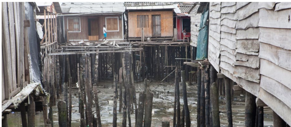
Viviendas palafíticas de Buenaventura
